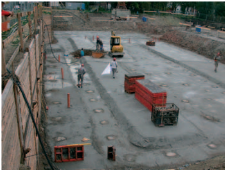
Die Bodenplatte des Neubaus Ende Oktober 2005.
