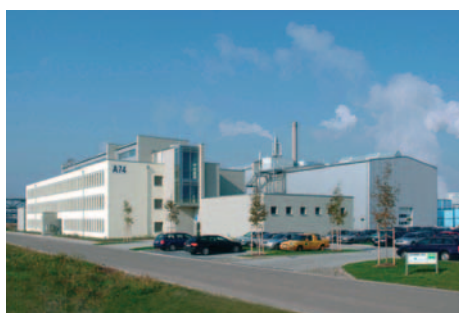
Das Fraunhofer-Pilotanlagenzentrum für Polymersynthesen und -verarbeitung in Schkopau
